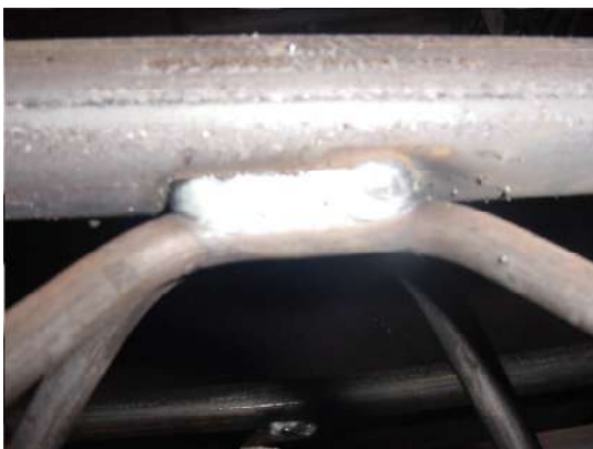
桁架式鋼支保加勁鋼筋焊接成品(圖十八)
