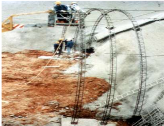
隧道洞口段桁架式鋼支保施工(圖一)
