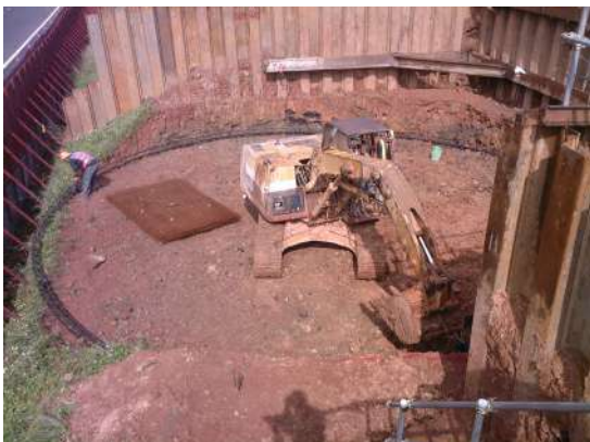
井式基礎支保放樣(圖九)
