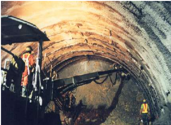
隧道內桁架式鋼支保施工(圖五)
