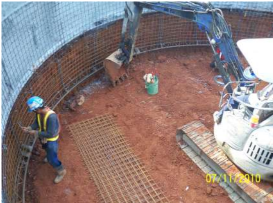
井式基礎鋼線網安裝(圖十三)
