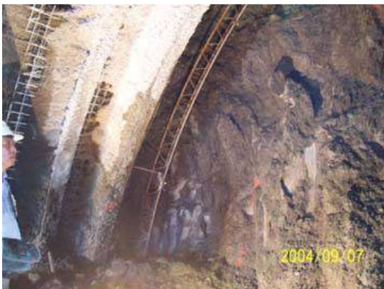
隧道內桁架式鋼支保施工(圖六)
