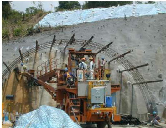
隧道洞口段桁架式鋼支保施工(圖二)
