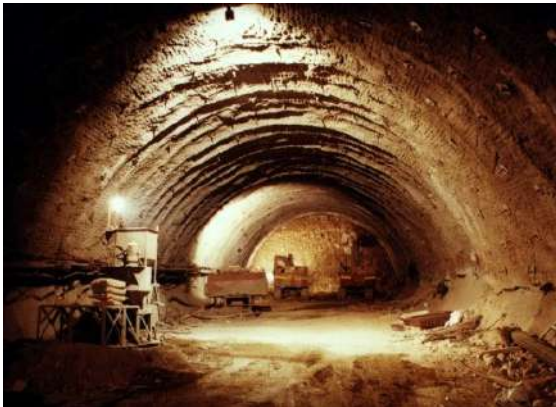
隧道內桁架式鋼支保施工(圖八)
