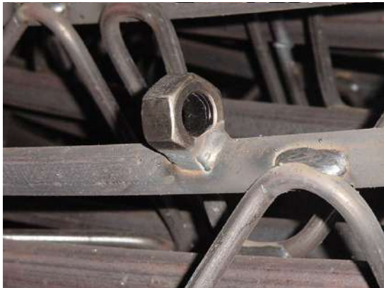
桁架式鋼支保繫桿座焊接成品(圖十七)
