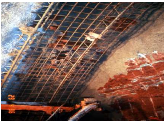
隧道內桁架式鋼支保施工(圖三)
