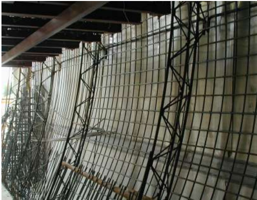
隧道內桁架式鋼支保施工(圖四)
