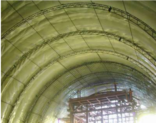
隧道內桁架式鋼支保施工(圖七)
