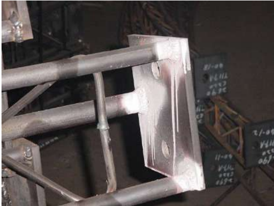
桁架式鋼支保接合端板焊接成品(圖十九)
