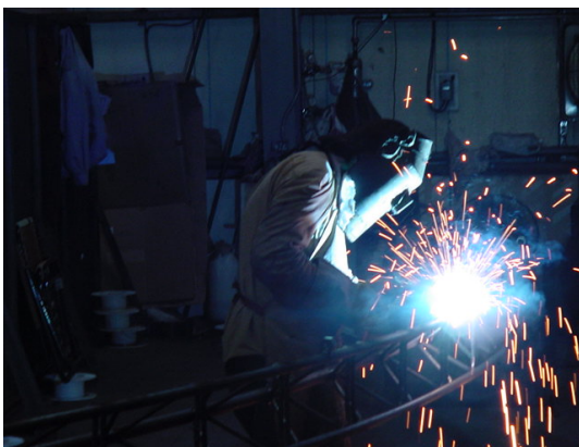
工廠內桁架式鋼支堡焊接情形(圖十五)
