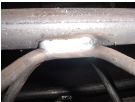
桁架式鋼支堡加勁鋼筋焊接成品(圖十八)
