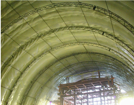
隧道內桁架式鋼支堡施工(圖七)
