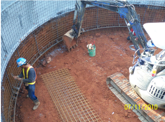
井式基礎鋼線網安裝(圖十三)
