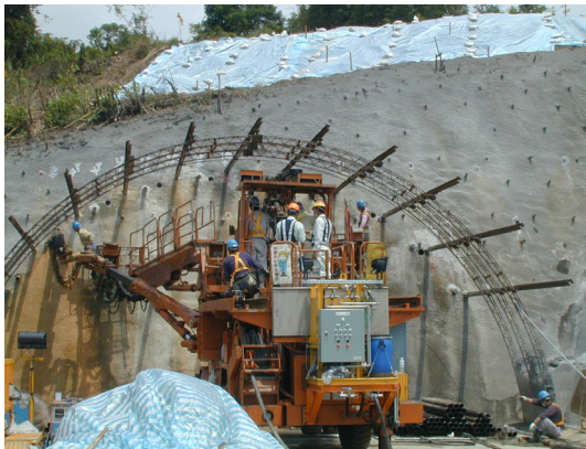
隧道洞口段桁架式鋼支堡施工(圖二)
