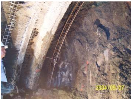
隧道內桁架式鋼支堡施工(圖六)
