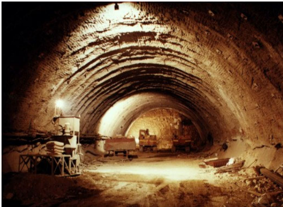
隧道內桁架式鋼支堡施工(圖八)
