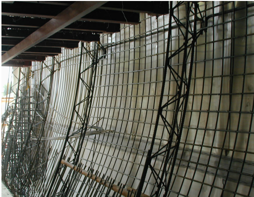
隧道內桁架式鋼支堡施工(圖四)
