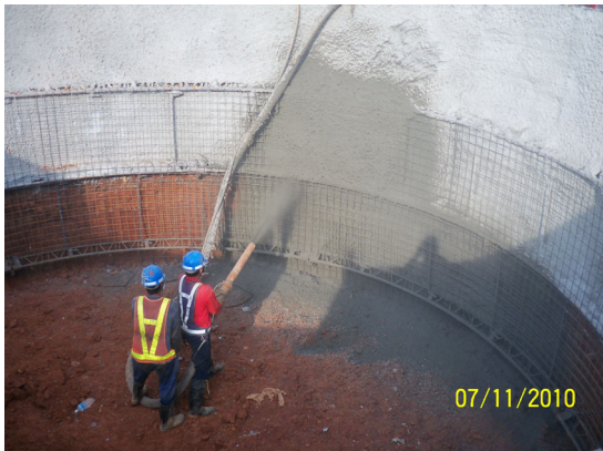
井式基礎支保安裝後噴漿(圖十四)
