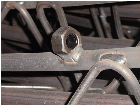
桁架式鋼支堡繫桿座焊接成品(圖十七)
