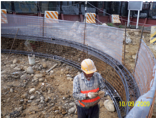
井式基礎支保安裝(圖十一)
