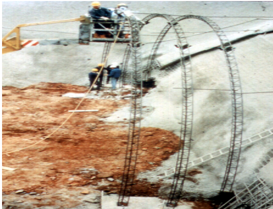
隧道洞口段桁架式鋼支堡施工(圖一)
