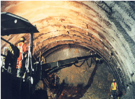
隧道內桁架式鋼支堡施工(圖五)
