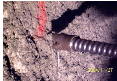
2. 自鑽式岩栓岩桿與拋棄式鑽頭
