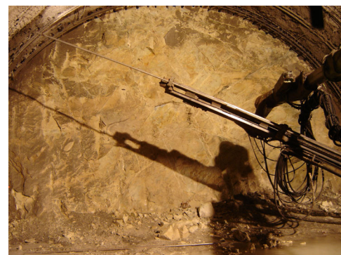
4. 自鑽式岩栓岩桿施工情形
