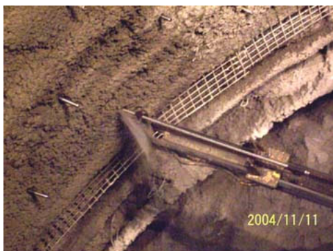
3. 自鑽式岩栓配合桁架式支保施工情形
