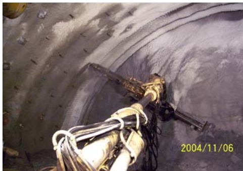
1. 自鑽式岩栓隧道內施工情形
