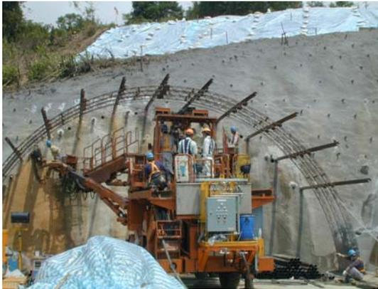
隧道洞口段桁架式鋼支堡施工(圖二)
