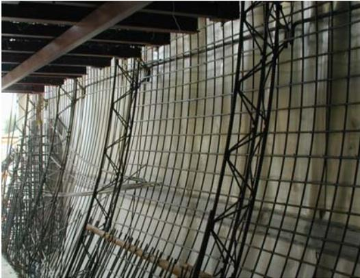
隧道內桁架式鋼支堡施工(圖四)
