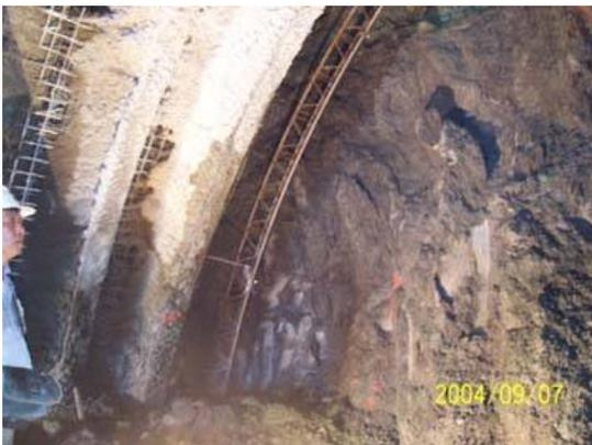
隧道內桁架式鋼支堡施工(圖六)
