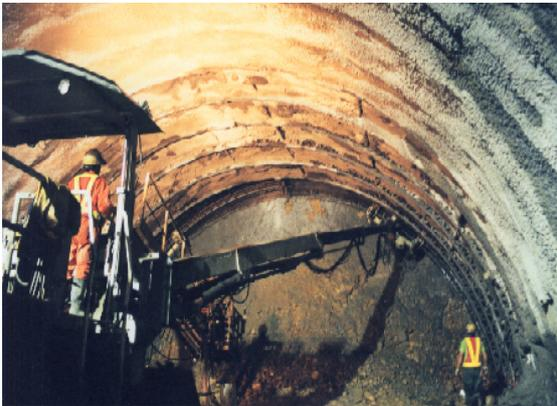
隧道內桁架式鋼支堡施工(圖五)
