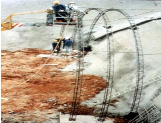
隧道洞口段桁架式鋼支堡施工(圖一)
