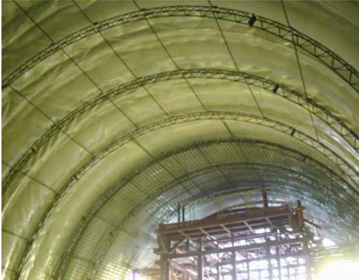
隧道內桁架式鋼支堡施工(圖七)
