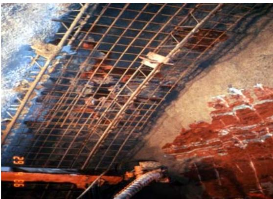
隧道內桁架式鋼支堡施工(圖三)
