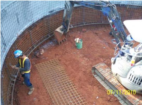
井式基礎鋼線網安裝(圖十三)
