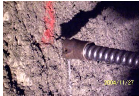
2. 自鑽式岩栓岩桿與拋棄式鑽頭
