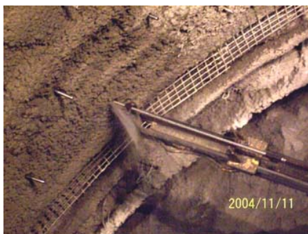
3. 自鑽式岩栓配合桁架式支保施工情形
