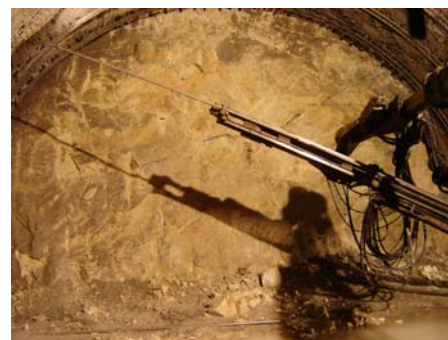
4. 自鑽式岩栓岩桿施工情形
