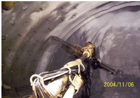
1. 自鑽式岩栓隧道內施工情形
